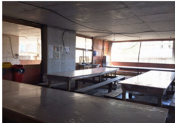
Figura 8 – Instalações provisórias priorizando iluminação e ventilação natural
