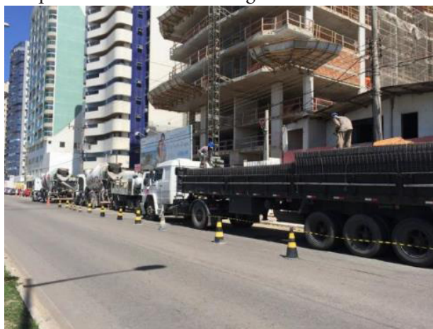
Figura 25 – Sinalização adequada em dia de concretagem e recebimento de carga
