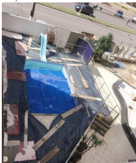
Figura 24 – Proteção para evitar sujeira no entorno
