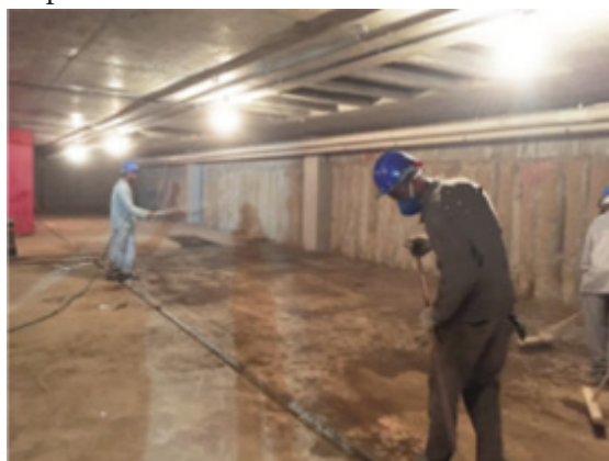
Figura 18 – Realização de limpeza umidificada
