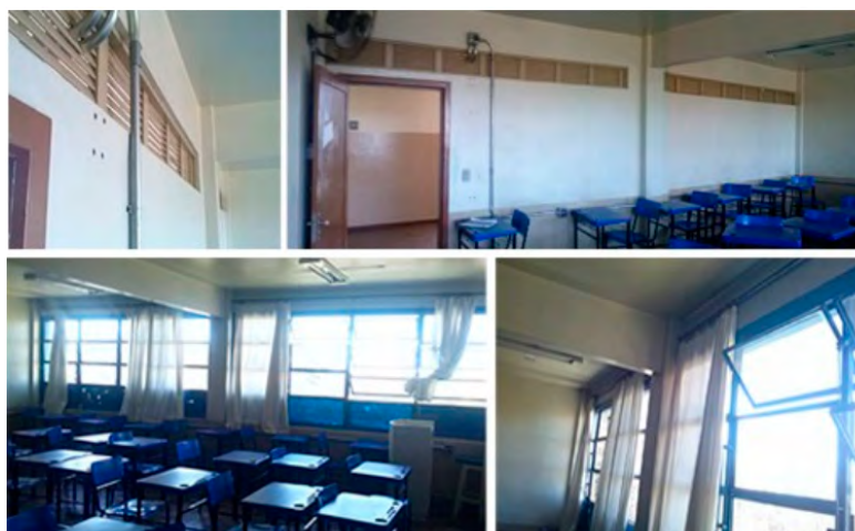
Figura 5. Fotografias internas das salas analisadas
